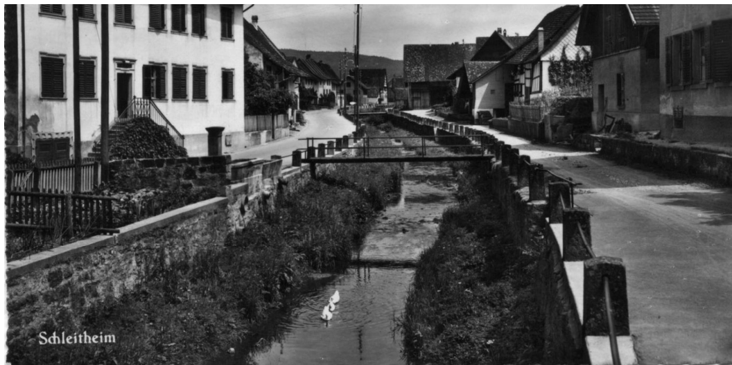
Abb. 20 ( undat., nach 1943 ) «Schleithheim» Rechtsufriges Mauerwerk des Schleitheimerbachs, von der Kronenbrücke aus gesehen, im Hintergrund Fussgängerbrücke 02. Vorne links: Gartenmauer mit Mauerversatz unterhalb Brunnen. Erstes Geländerstein R10. Q: PK-schlaate.info, Bild-Nr. 5216.
