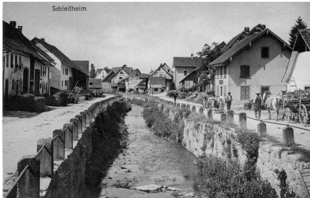
Abb. 21 ( undat. ) «Schleithheim» Rechtsufriges Mauerwerk des Schleitheimerbachs, von der Rösslibrücke aus gesehen, im Hintergrund Fussgängerbrücke 01. Vorne rechts: Mauerversatz bei R106. Q: PK-schlaate.info, Bild-Nr. 5206.
