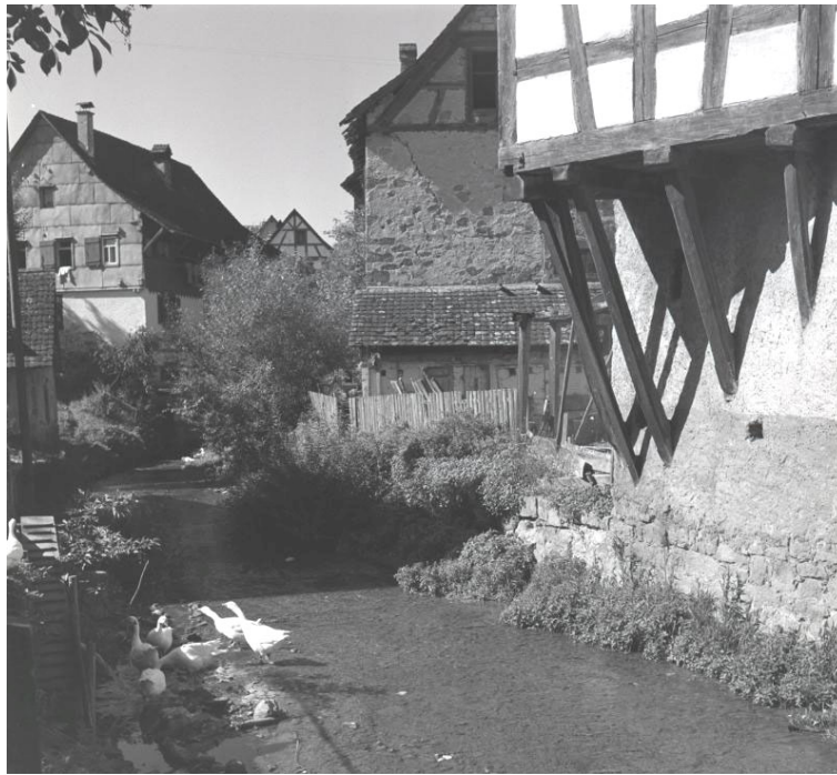
Abb. 7 Okt. 1950 Das zurückgesetzte Kellergeschoss und der Gebäudeüberstand der Bierbrauerei Stamm ist Folge der Bachbegradigung an diesem Ort. Die tragenden Stützen wurden Ende der 1960er-Jahre zugunsten eines befensterten Kellergeschosses entfernt. Q: Sammlung Ernst Brunner, Fotoarchiv Schweizerische Gesellschaft für Volkskunde SGV, Sign. SGV_12N_36962 (alt: PU 82)
