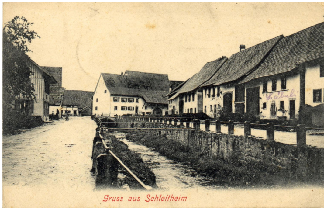
Abb. 22 (undat.) «Gruss aus Schleithelm» (rechts: Häbeli). Linksufriges Mauerwerk des Schleithemberbachs, unterhalb des Fussgängerstegs 01 aus gesehen, im Hintergrund Rösslibrücke. Q: PK-schlaate.info, Bild-Nr. 5208.
