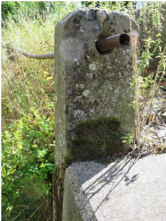
Abb. 59 2020. Bachgeländersteine der zweiten Generation ggü. Brauerei Stamm (L206). Masse: H: 56 (77) cm, Basis 30.5 cm, Kopf 30 cm, Giebelkappung 5 cm, Bohrung ab Basis 38 (59) cm. Q: Osoegawa, Aug. 2020
