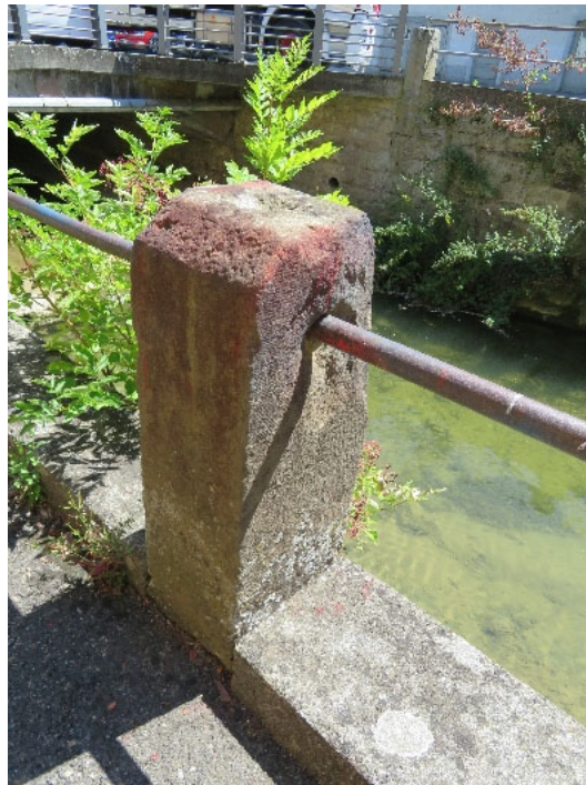
Abb. 60 2020. Bachgeländersteine der zweiten Generation in der Hofstatt, oberseitig mit runder Einkerbung für Eisenring, analog der 1. Generation. Masse: H: 77 cm, Basis 30 cm, Kopf 30 cm, Giebelkappung 5 cm, Bohrung ab Basis 66 cm. Sockelbasis verbreitert, roh gebrochen, H. 50 cm, Gesamtsteinhöhe 127 cm. Q: Osoegawa, Aug. 2020
