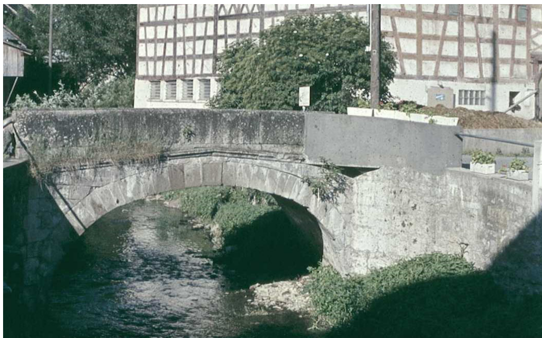
Abb. 49 (undat., vor 1970) Kronenbrücke mit frisch gesetzter Betonbrüstung (selbige vor 1966 erstellt). Zum Zeitpunkt der Aufnahme besass die Bierbrauerei Stamm bereits ein neues Sockelgeschoss. Q: Stadtarchiv Schaffhausen, Fotonachlass Willy Pletscher († 1970), Bild-Nr. 324942_J-18.06.05
