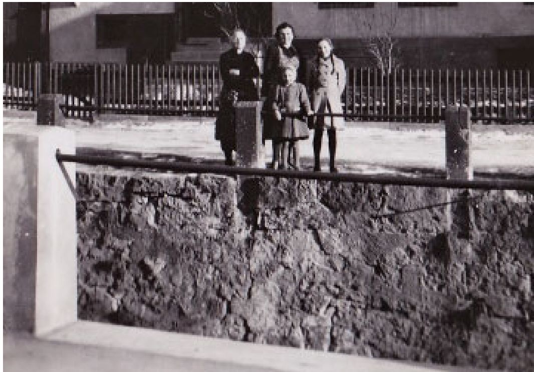
Abb. 23 (undat., nach 1943) Linksseitige Ufermauer auf Höhe von Haus «Grütli», unmittelbar nach Sanierung der Beggingerstrasse. Q: Postkarte, Fotoarchiv Schaffhausen, ohne Sign. (Ausschnitt).
