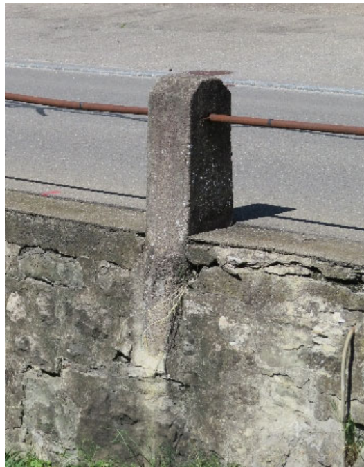
Abb. 66 2020 Bachgelderstein, Typ Eberfingerstein, analog Entwurf Baugeschäft H. Pletscher-Proyer. Masse: H: 77 cm, Basis 37 cm, Kopf 30 cm, Bachseite 28 cm, Giebelkappung 7 cm, Bohrung ab Basis 63 cm. Q: Osoegawa, Aug. 2020.
