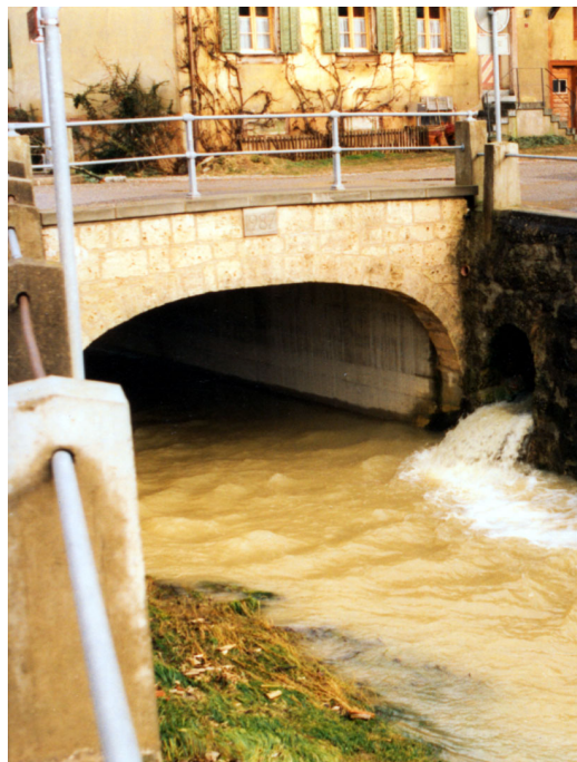
Abb. 42 (undat., vor Dez. 1989), Rösslibrücke Nachzustand Sanierung, von Westen her gesehen. Q: Walter Schwarz, Ingenieurbüro 8180 Bülach (1995, S. 8).
