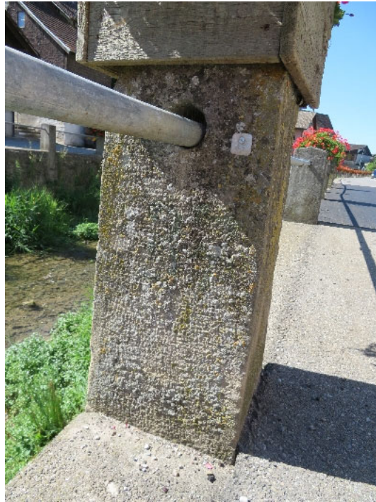
Abb. 62 2020 Bachgeländerstein der dritten Generation, hier mit ostseitig gestockter Oberfläche und Randschlag, Beggingerstrasse (unvermasst). Q: Osoegawa, Aug. 2020.
