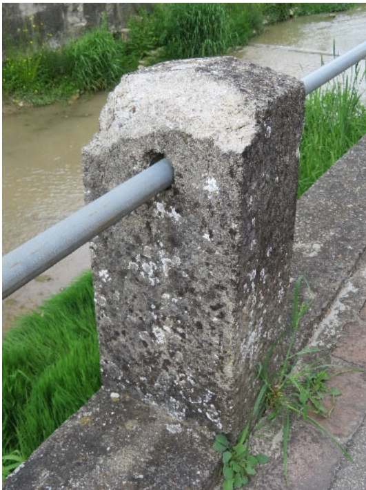
Abb. 63 2020 Bachgeländerstein der vierten Generation (1930er-Jahre) mit abgeriebener Oberfläche, Bachstrasse / Eberlibrücke. Masse: H: 74 cm, Basis 32 cm, Kopf 28 cm, Bachseite 25 cm, Giebel 3 cm, Bohrung ab Basis 60 cm. Q: Osoegawa, Mai 2020.
