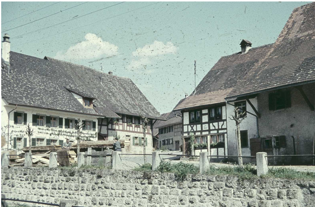
Abb. 38 (undat., nach 1951) «Im Raa». Die 1951 neu erstellte linksseitige Ufermauer (L263 bis L271) unterhalb der Adlerstrasse 35. Q: Stadtarchiv Schaffhausen, Sammlung Willy Pletscher, Sign. 325096, Neg. J_18.06.05.
