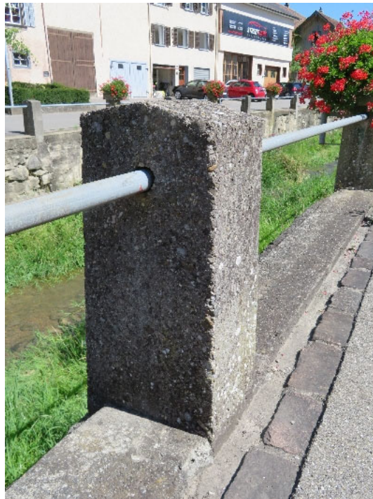
Abb. 64 2020 Bachgeländerstein der vierten Generation mit Zuschlag analog Betonabdeckung (1941/47), Beggingerstrasse. Masse: H: 75 cm, Basis 36 cm, Kopf 30 cm, Bachseite 25 cm, Giebel 3 cm, Bohrung ab Basis 60 cm. Q: Osoegawa, Aug. 2020.
