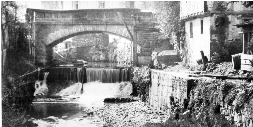
Abb. 50 (1920/21) Rote Brücke mit Wehr und Mühlekanal (rechts) samt Betonplombe. Q: Fotoarchiv Koch / Schiendorfer (Hg.), S. 99 (Ausschnitt).
