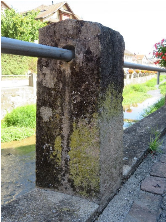
Abb. 61 2020 Bachgeländerstein der dritten Generation mit allseitig gespickter Oberfläche (1889/90), Bachstrasse auf Höhe Haus Frohsinn. Masse: H: 75 cm, Basis 34 cm, Kopf 30 cm, Bachseite 30 cm, Giebel 5 cm, Bohrung ab Basis 60 cm. Q: Osoegawa, Mai 2020.
