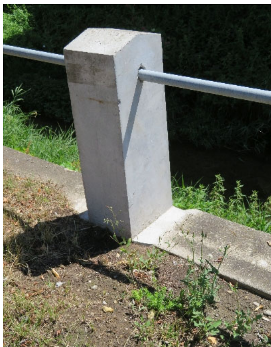
Abb. 67 2020 Bachgeländerstein der fünften Generation scharfkantig, mit abtalschierter Oberfläche, ohne konische Verjüngung und Oberflächenbearbeitung, nach einem Entwurf von Ing. Walter Schwarz (1988), Poststrasse. Q: Osoegawa, Aug. 2020.
